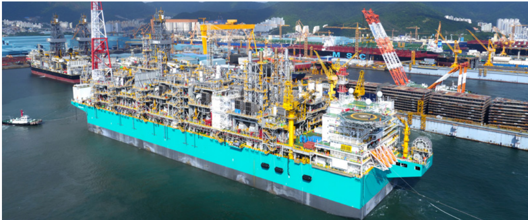
부유식 액화천연가스설비(F LNG, Floating Liquefied Natural Gas)
